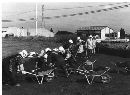
作業風景〈浮土排土〉（西から）
