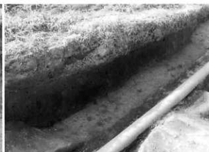
5 調査区西壁 南東から
