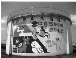
写真1 既存の配水タンク
