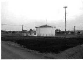
写真4 埋め戻し後(北から撮影)
