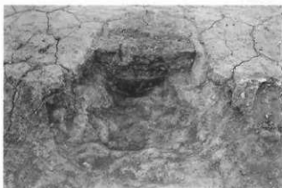
8. SB02 切欠断面 南から
