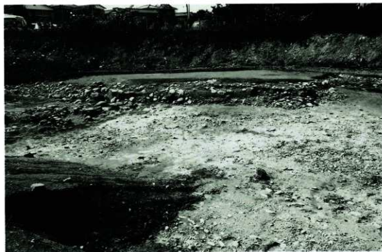
護岸工事跡および造成面（東より）
