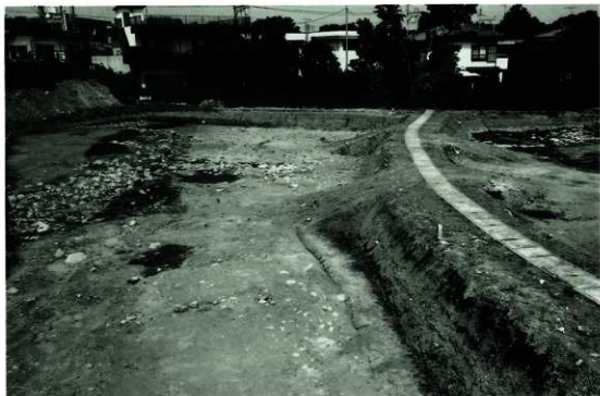
護岸工事跡北側（南より）
