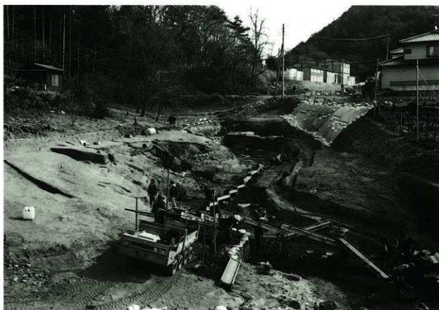
東側灰原（西から）
