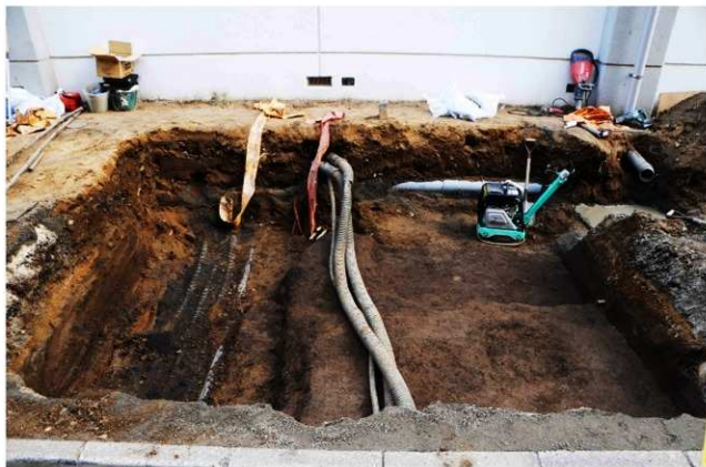
写真 57 文京 72 次 (02002 調査) I 区表土層除去状況 (南から)
