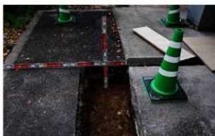
写真 247 20106 調査 北端部の状況（南西から）
