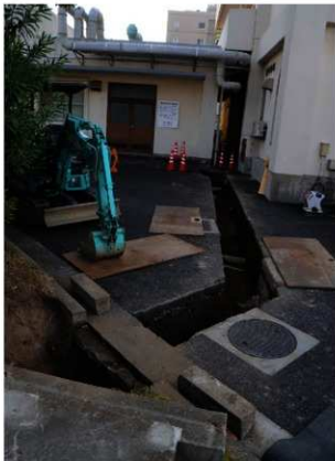
写真258 02107調査 2区全景 (西から)
