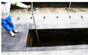
写真99 02003調査Ⅰ区西端（南から）
