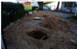
写真 318 榊味 20 次 (02109 調査) 23 トレンチと 24 トレンチ遠景 (西から)
