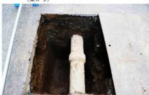
写真 91 文京 72 次 (02002 調査) II 区南部完掘状況 (東から)
