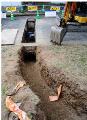
写真 123 02005 調査 1 トレンチ全景 (東から)
