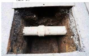
写真 92 文京 72 次 (02002 調査) II 区南部完掘状況 (南から)
