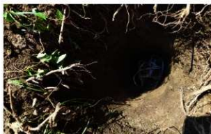
写真165 02102 調査2 トレンチ掘削状況
