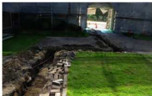
写真 43 02001 調査 2-5・6・7 区全景 (西から)
