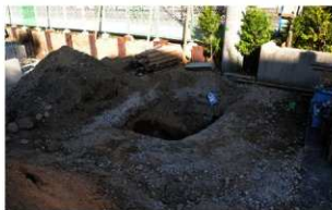
写真 241 文京 74 次 (02105 調査) 7 トレンチ遠景 (南西から)
