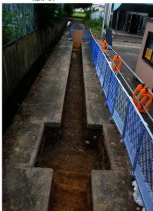
写真173 横穴19次 (02103調査) 2トレンチ全景 (北から)
