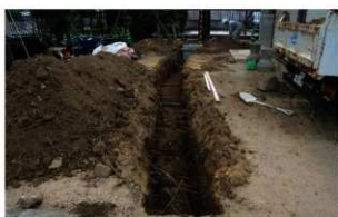
写真 23 02001 調査 1 区西半分全景 (東から)
