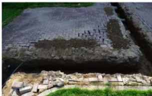
写真 44 02001 調査 2-6 区全景 (西から)
