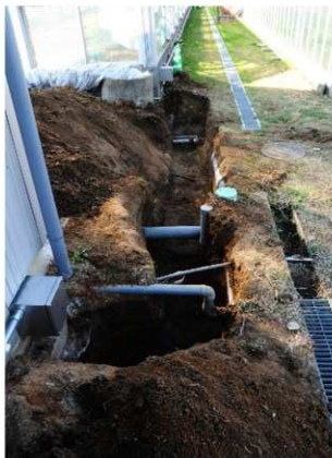
写真 129 02005 調査 2 トレンチ全景 (東から)
