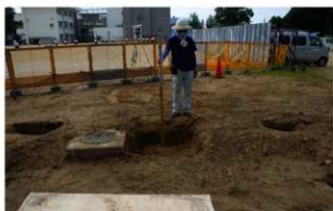
写真 51 02001 調査 3 区地点①全景 (東から)
