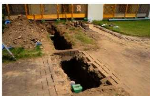
写真 31 02001 調査 2-3 区全景 (南西から)
