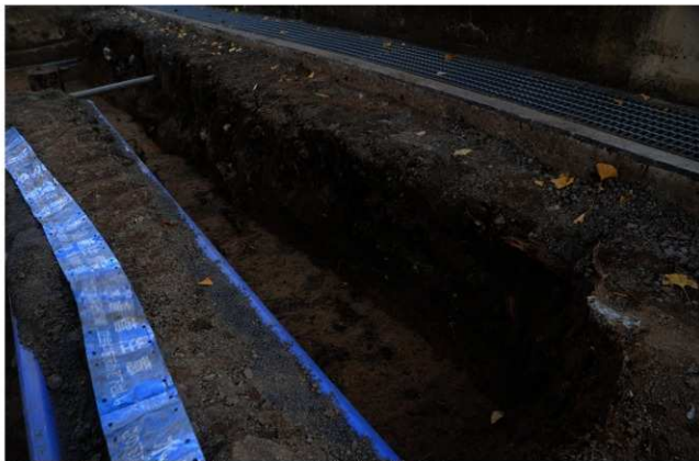
写真 217 樽味 19 次 (02103 調査) 12 トレンチ南東部全景 (南西から)
