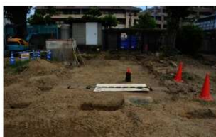
写真 50 02001 調査 3 区全景 (西から)
