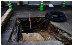
写真 244 20106 調査 南端部西壁土層 (東から)
