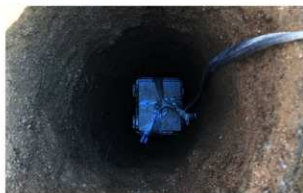
写真163 02102 調査1 トレンチ掘削状況
