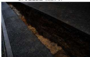
写真 211 樽味 19 次 (02103 調査) 11 トレンチ SX-5 土層断面 (北東から)
