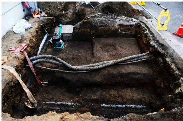
写真 61 文京 72 次 (02002 調査) I 区表土層除去状況 (西から)
