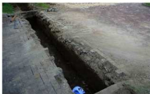
写真 29 02001 調査 2-2 区全景 (南西から)
