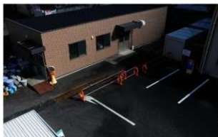
写真 251 02107 調査 1-1 区全景 (南西から)
