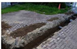
写真 47 02001 調査 2-7 区全景 (南西から)
