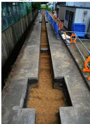
写真174 横穴19次 (02103調査) 2・3トレンチ全景 (北から)
