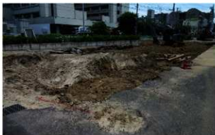
写真 157 文京 73 次 (02101 調査) 既設管路撤去状況 (北西から)
