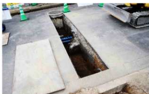
写真 124 02005 調査 1 トレンチ西側全景 (南東から)
