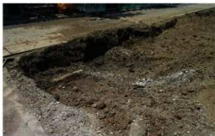
写真 156 文京 73 次 (02101 調査) 既設管路撤去状況 調査区南西部 (南東から)
