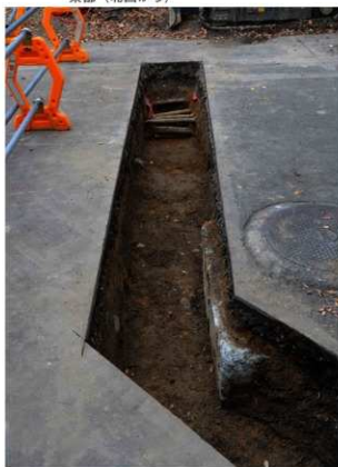
写真 190 榑味 19 次 (02103 調査) 6 トレンチ 北西部全景 (南から)
