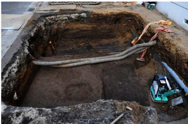
写真 59 文京 72 次 (02002 調査) I 区表土層除去状況 (東から)
