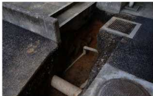
写真256 02107調査 2-1区東端部完掘状況 (北西から)
