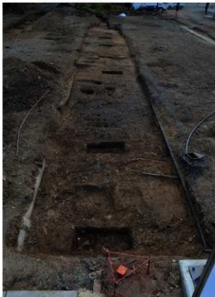
写真 333 榑味 20 次 (02109 調査) 29 トレンチ 完掘状況 (西から)
