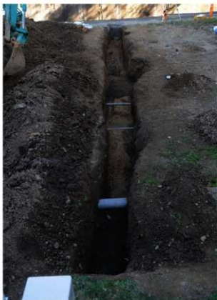
写真 198 樽味 19 次 (02103 調査) 9 トレンチ 全景 (西から)
