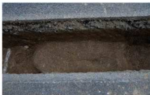
写真252 02107調査 1-1区中央部南壁土層 (北から)
