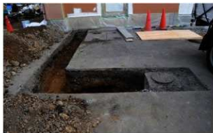
写真 351 樽味 20 次 (02109 調査) 32 トレンチ全景 (西から)
