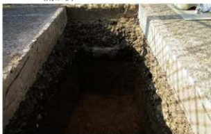
写真 180 榑味 19 次 (02103 調査) 4 トレンチ 北端部全景 (南から)
