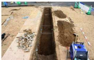
写真 112 02003 調査 III 区全景 (西から)
