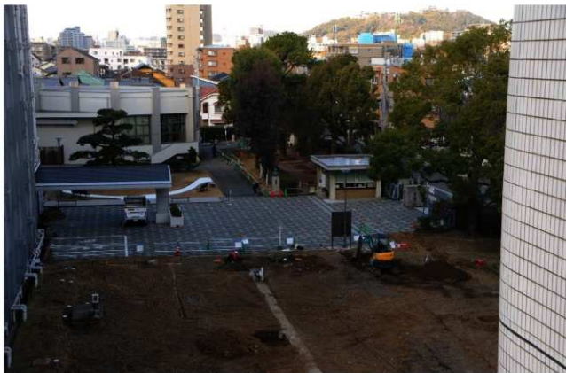
写真 267 榊味 20 次 (02109 調査) 1 区全景 (東から)
