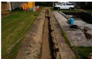
写真 38 02001 調査 2-5 区全景 (西から)
