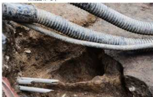
写真 85 文京 72 次 (02002 調査) SP-9 完掘状況 (北西から)
