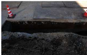
写真 238 文京 74 次 (02105 調査) 6 トレンチ土層 (東から)
