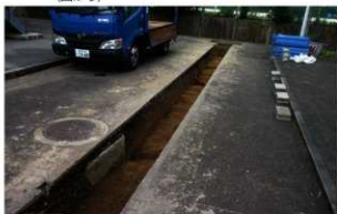
写真169 榑味19次 (02103調査) 1トレンチ調査区全景 (南西から)
