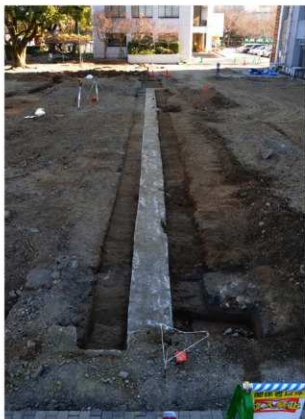
写真 346 榑味 20 次 (02109 調査) 30 トレンチ全景 (西から)
