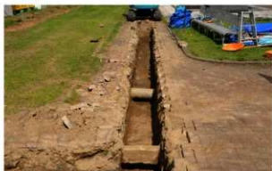
写真 35 02001 調査 2-5 区全景 (西から)
