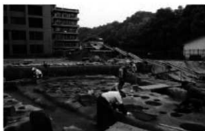
図2 調査作業風景（1）
