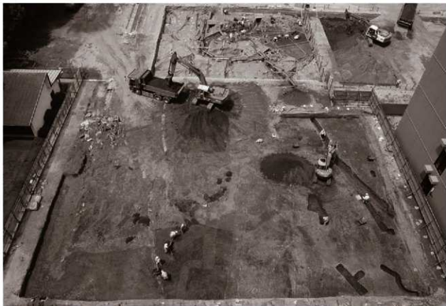
1 : 16次調査A区の表土掘削作業及びⅢ層上面の検出作業の状況（南から）
