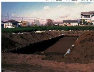
4. I地区 調査地全景 (南から)
