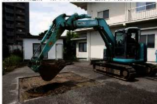
1. 1Tr 重機掘削の様子 (北東から)
