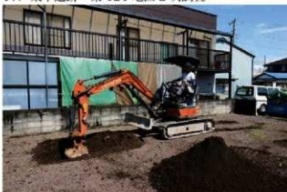
1. 1Tr重機掘削の様子（南東から）
