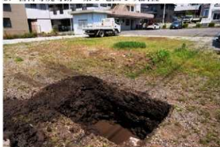
1. 1Tr完掘 (南東から)
