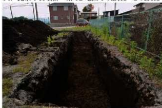
1. 3Tr 完掘 (南東から)
