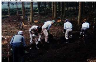
1. 1Tr 人力掘削の様子
