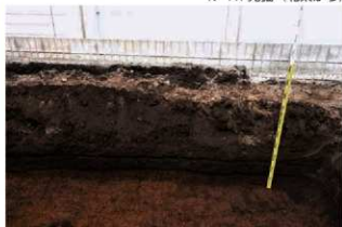
2. 1Tr土層堆積 (北から)
