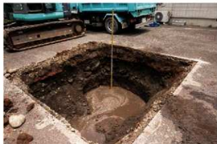
2. 1Tr 完掘 (南東から)
