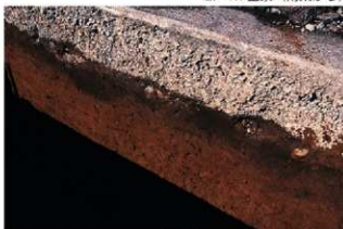
4. 6Tr 東西セクション北壁 (南東から)
