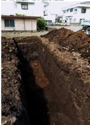
1. 2Tr完掘（南東から）
