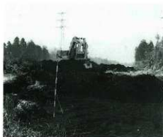
重機による表土除去作業
