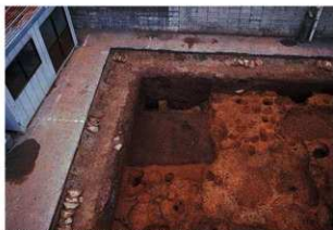
(1) SK13 掘削状況① (北西から)
