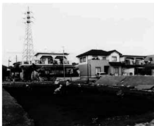
第4図 作業風景（南西から）
