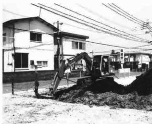
(3) 表土剥ぎ状況 (南東から)
