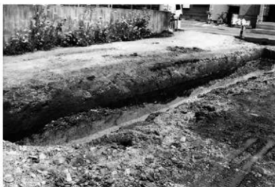
第14図 調査区西壁土層堆積状況（南東から）
