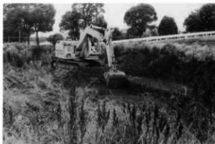
(2) 重機による表土剥ぎ
