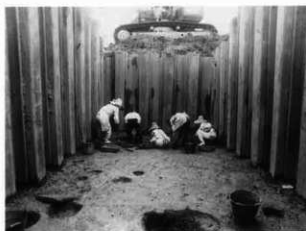
(2) 作業風景① (南から)
