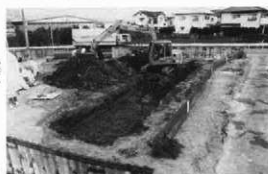
Fig.100 重機による表土剥ぎ風景
