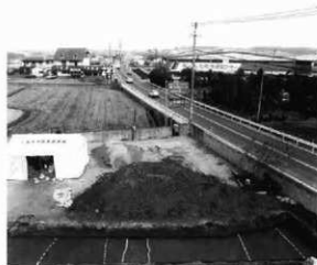
Fig.115 調査地より北方を望む(南から)
