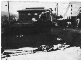
重機による表土剥ぎ風景
