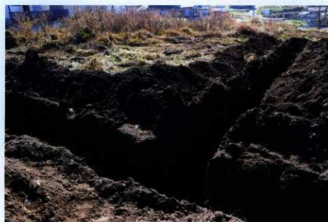
トレンチ掘削状況
