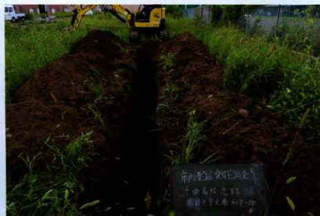
トレンチ掘削（西から）
