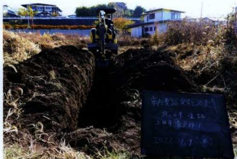
Tr-01 掘削（北から）
