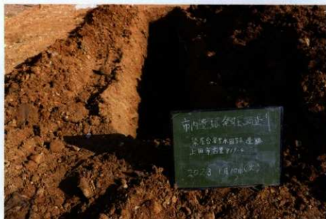
Tr-02 掘削（西から）
