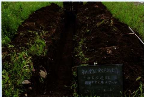
Tr-01 トレンチ掘削（東から）
