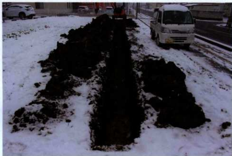
トレンチ掘削（北から）
