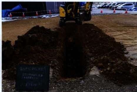
トレンチ掘削状況（北から）
