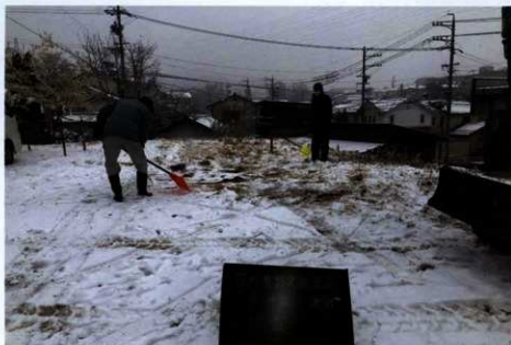
除雪作業（西から）
