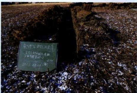
Tr-02 掘削状況（南から）
