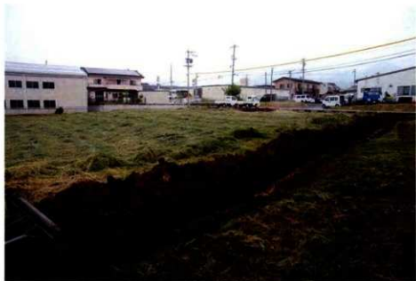
トレンチ掘削（南西から）
