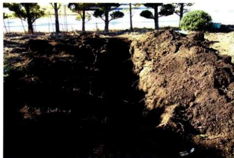
トレンチ掘削（東から）
