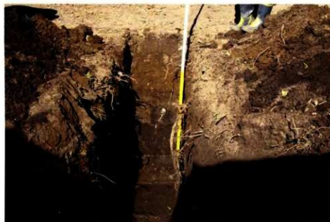
トレンチ掘削（西から）
