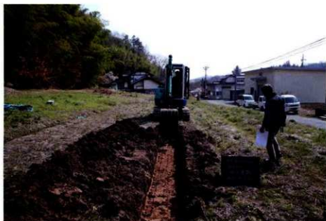
トレンチ掘削（西から）
