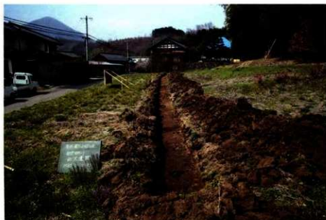
トレンチ掘削（東から）
