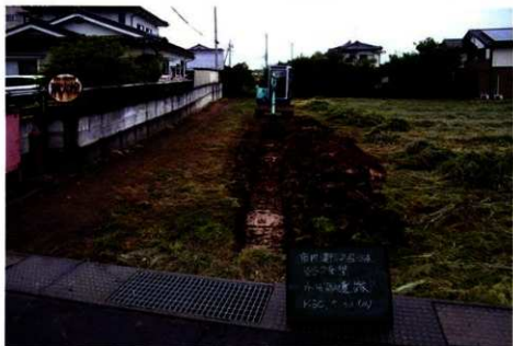
トレンチ掘削（東から）
