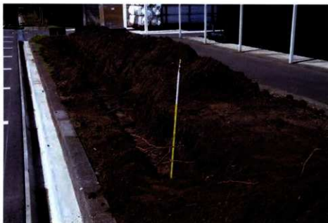
Tr-01 掘削状況（北東から）
