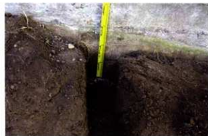
写真7 土塁版築土の破壊状況 H30
