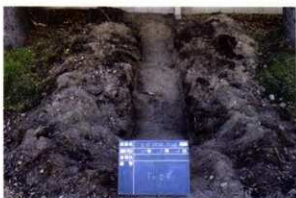
写真6 二の丸広堀土塁の残存状況 H30
