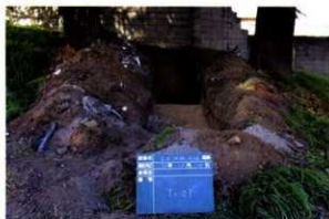
写真5 二の丸広堀土塁の残存状況 H30
