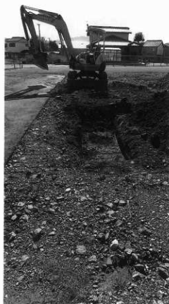
重機による確認調査の様子
