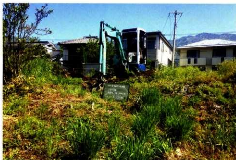
トレンチ掘削（南から）
