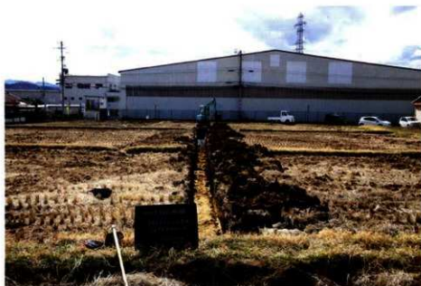
トレンチ掘削（東から）
