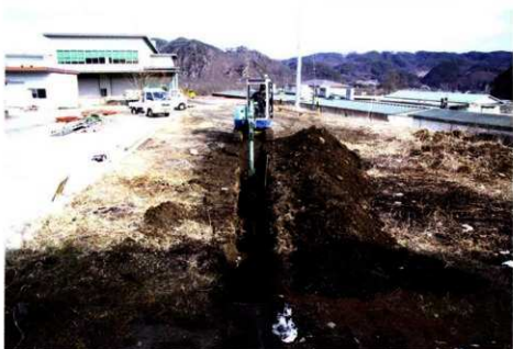
トレンチ掘削（西から）
