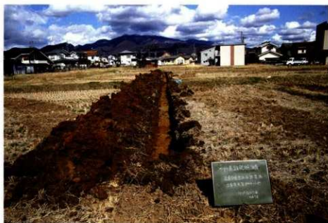
トレンチ掘削（西から）
