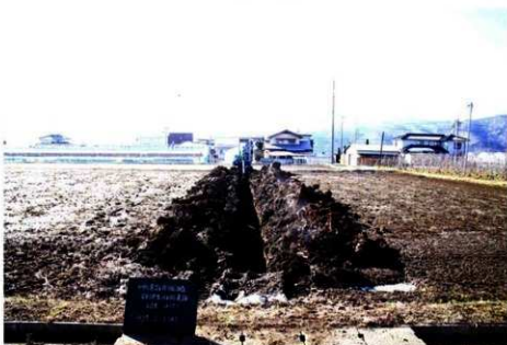
Tr-01 掘削状況（北から）
