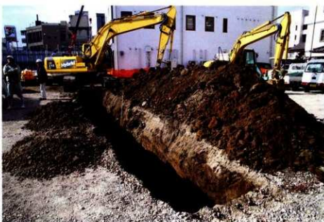
トレンチ掘削（北東から）
