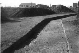
第4区 東側 状況（東より）
