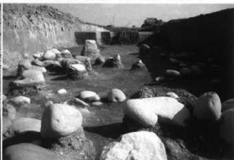
高ノ町遺跡4地点 SD-04 掘削状況（西より）
