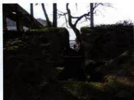
写真 36 土壁状盛土の半載状況
