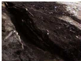
写真 65 法面トレンチ掘削状況
