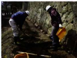
写真 17 トレンチ掘削状況
