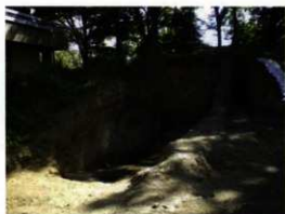
写真 75 土壘状盛土の調査完了状況
