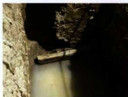
写真 78 土壘跡地トレンチ掘削状況
