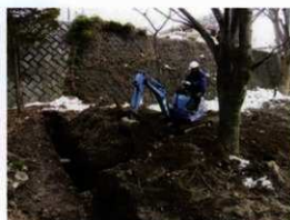
写真 82 トレンチ掘削状況
