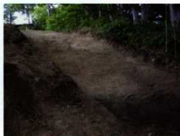
写真 66 櫓台状盛土のトレンチ掘削状況
