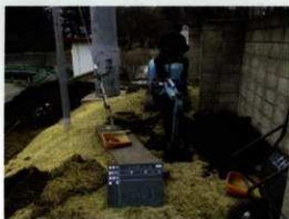
写真 83 土壘状盛土トレンチ掘削状況
