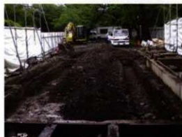
写真 27 旧社務所解体撤去時の状況
