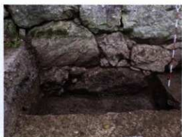
写真 4 調査区東側石垣の根石
