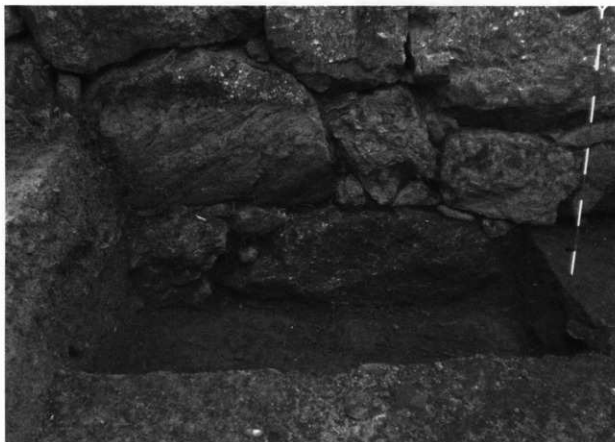
第 42 図 平成 24 年度調査区東側壁土層断面の状況
