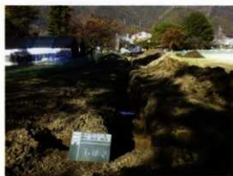
写真 44 調査区 (2) トレンチ掘削状況
