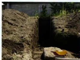
写真 49 プール南側盛土トレンチ掘削状況
