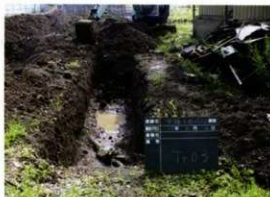
写真 48 プール跡地トレンチ掘削状況
