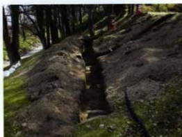
写真 35 トレンチ完掘状況
