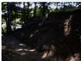
写真 76 土壘状盛土の断面調査完了状況
