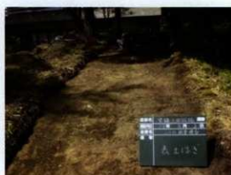
写真 64 土塁状盛土天端の調査状況
