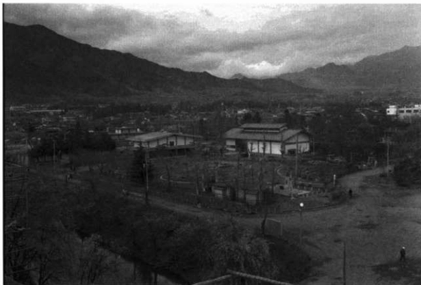
第17図 南櫓から二の丸東虎口・三の丸樹木屋敷方面を望む(昭和42年)
