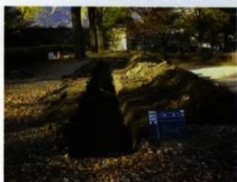
写真 47 同左トレンチ掘削状況
