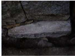
写真 21 石垣根石（北側隅）の検出状況
