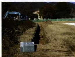
写真 45 調査区 (2) トレンチ掘削状況
