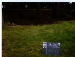
写真 63 土塁状盛土の法面の調査状況
