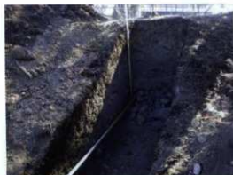
写真 32 土壁状盛土の半載状況
