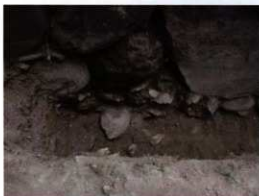
写真 7 石垣根石の状況
