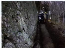
写真 16 石垣根石の状況
