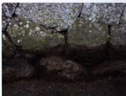
写真 15 石垣根石の状況
