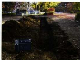
写真 46 旧伝染病院跡地トレンチ掘削状況
