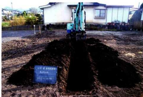
トレンチ掘削（西から）
