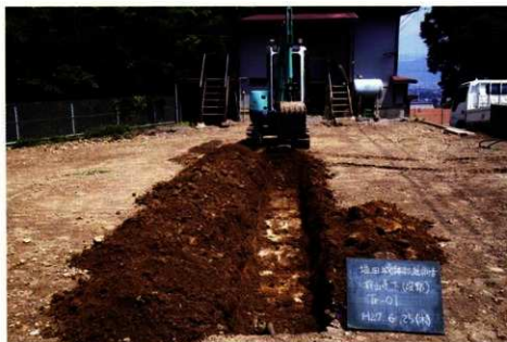
トレンチ掘削（南から）
