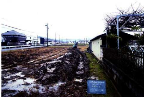
トレンチ掘削（北から）
