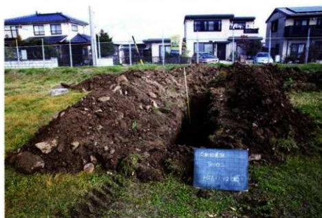
Tr-02 掘削（南から）
