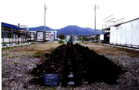
Tr-01 掘削（南から）
