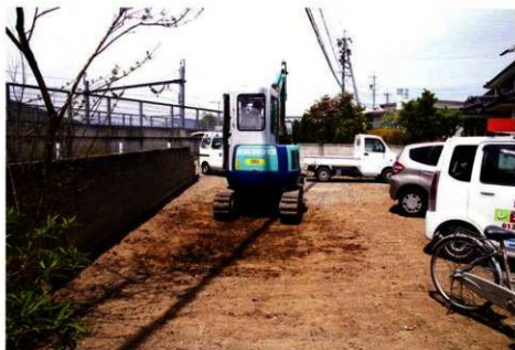
Tr-01 埋め戻し (東から)
