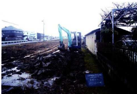
トレンチ掘削（北から）
