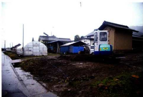
トレンチ掘削（北西から）
