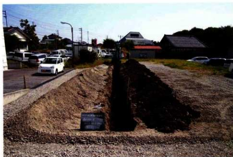
トレンチ掘削（西から）
