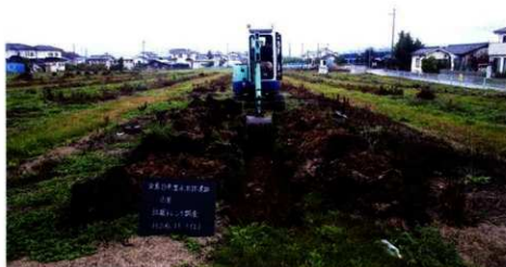
Tr-01 掘削（東から）
