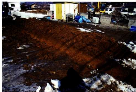
トレンチ掘削状況（南東から）
