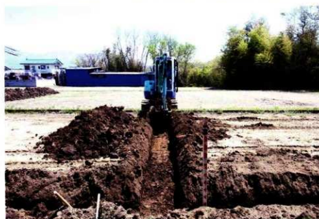
Tr-03 セクション (西から)
