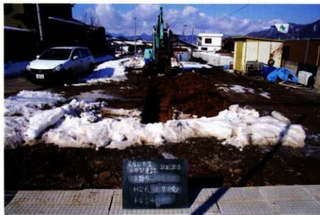
トレンチ掘削状況（南から）
