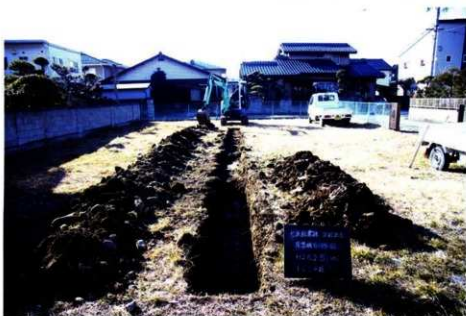
トレンチ掘削状況（北から）
