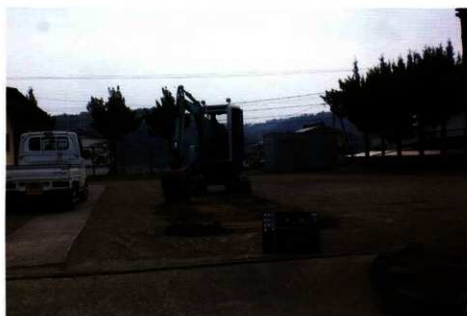
トレンチ掘削（西から）
