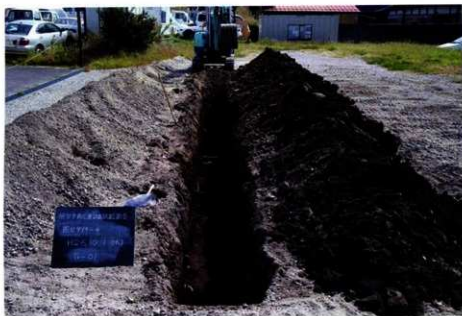
トレンチ掘削（西から）
