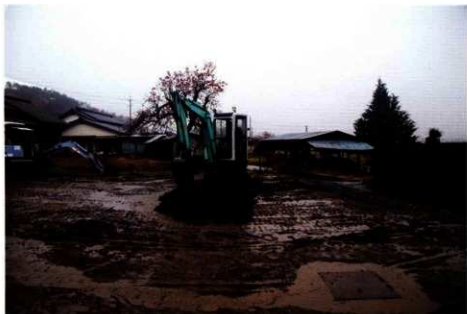
トレンチ掘削（東から）
