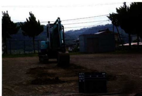
トレンチ掘削（西から）
