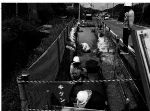
写真2 人力による掘削作業状況
