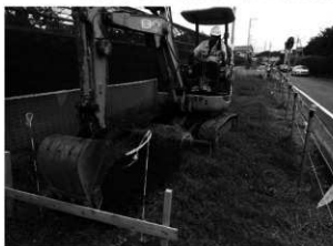
写真1 重機による表土掘削作業状況
