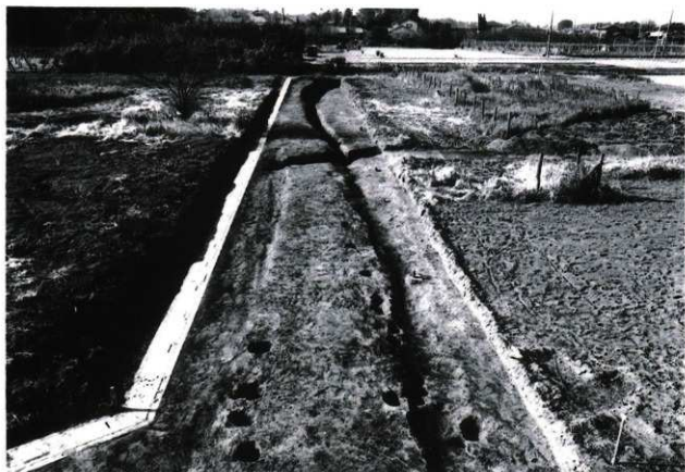
第11次調査全景 (1)
