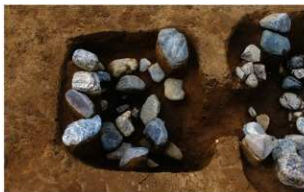
2 第2号建物跡第2号礎石基礎 (上面)
