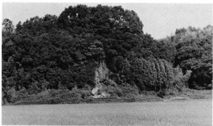
台風で崩壊した崖面 3
