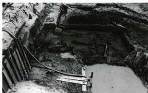
下段堰検出状況 (西側から)
