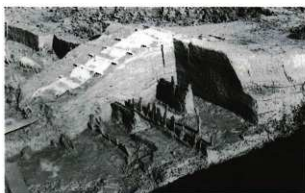
堰盛土立割状況
