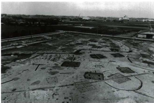
調査区全景(南側から)
