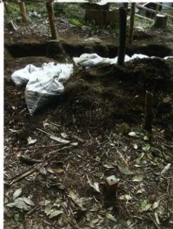
(3) 基準点設置状況 (写真左 白色ポイント)
