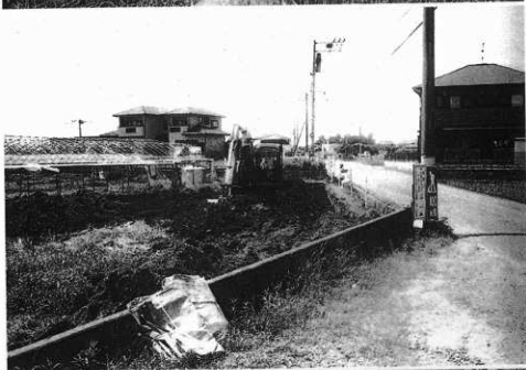
重機による表土除去
