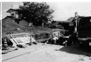
6. 5工区立坑掘削 (110-2番地付近、南西から)
