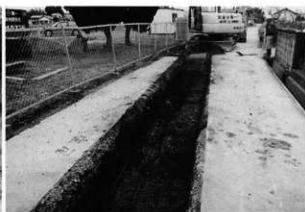
4. 8工区T-1 作業風景 (東から)
