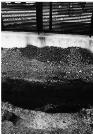
3. 31 工区溝（北側、南東から）
