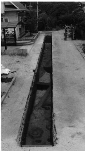
2. T4-2 全景 (南から)
