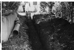
4. 248 工区立会 (北から)
