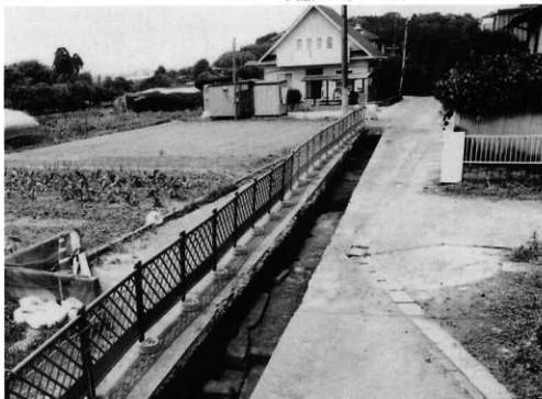
1. T-2全景 (南から)
