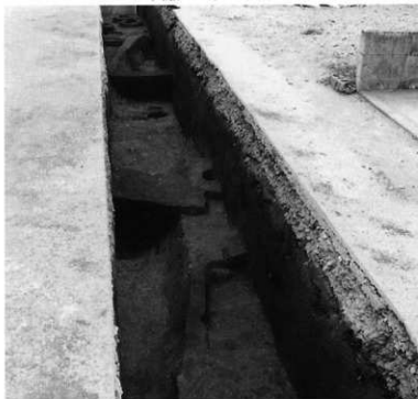
1. T4-2 溝 SD-65 (北東から) 手前が11mセクション
