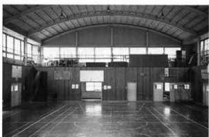
3 体育館内部（北側）
