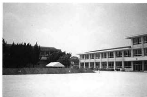
1 体育館東区全景
