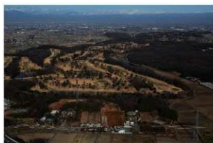
2 A区遠景（南から）
