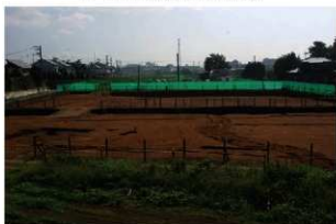
3 石神Ⅲ遺跡全景（北から）
