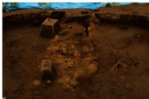
6 第55号住居跡カマド構築土検出状況
