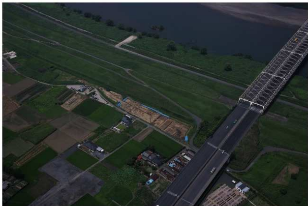
1 調査区近景（南東から）
