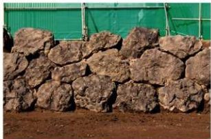
3 石垣検出状況 (3)
