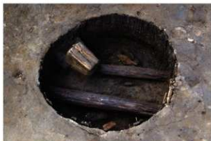
1 第 301 号埋設桶 南から
