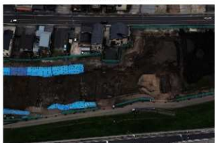
4 調査区全景 (第4次調査)
