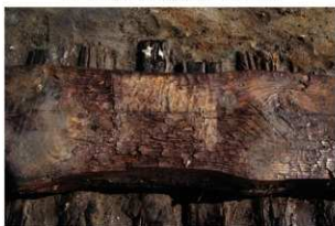
3 第301号建物跡 南側基礎墨打ちの線
