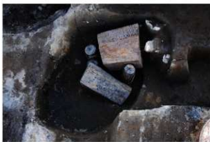
8 第602号建物跡南西隅基礎 東から
