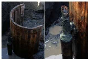
3 第 306 号井戸跡給水筒 南から
