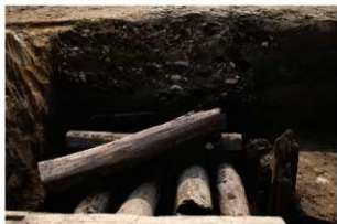
2 第307b号建物跡北側基礎西断面 東から
