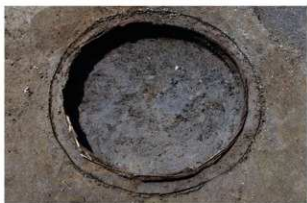
3 第 624 号埋設桶 南から
