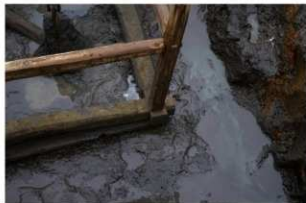
3 第3号井戸跡木組み構築状況
