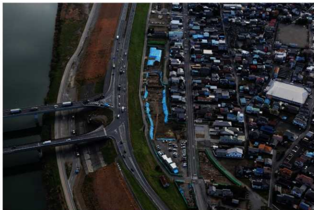
1 調査区近景 北から
