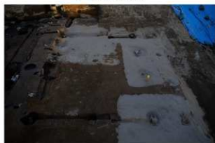
8 第201号建物跡基礎杭検出状況
