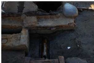
4 第 212・214 号埋設桶竹樋断面
