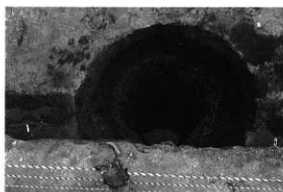
5区SE1 南から
