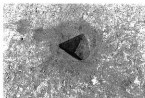
5区SA2 構の先端の痕跡
