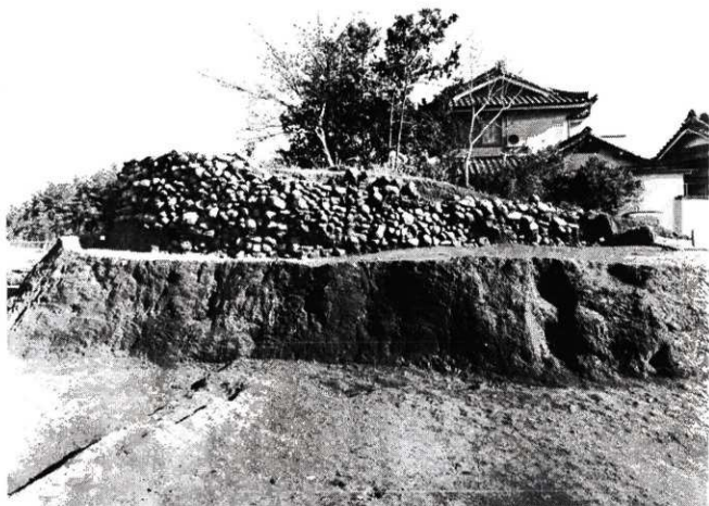
4区1号墳裏込被覆西側（東より） 9
