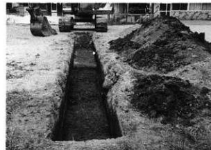
トレンチ 西から
