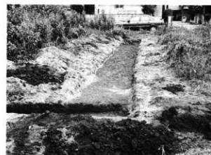
南トレンチ 北から
