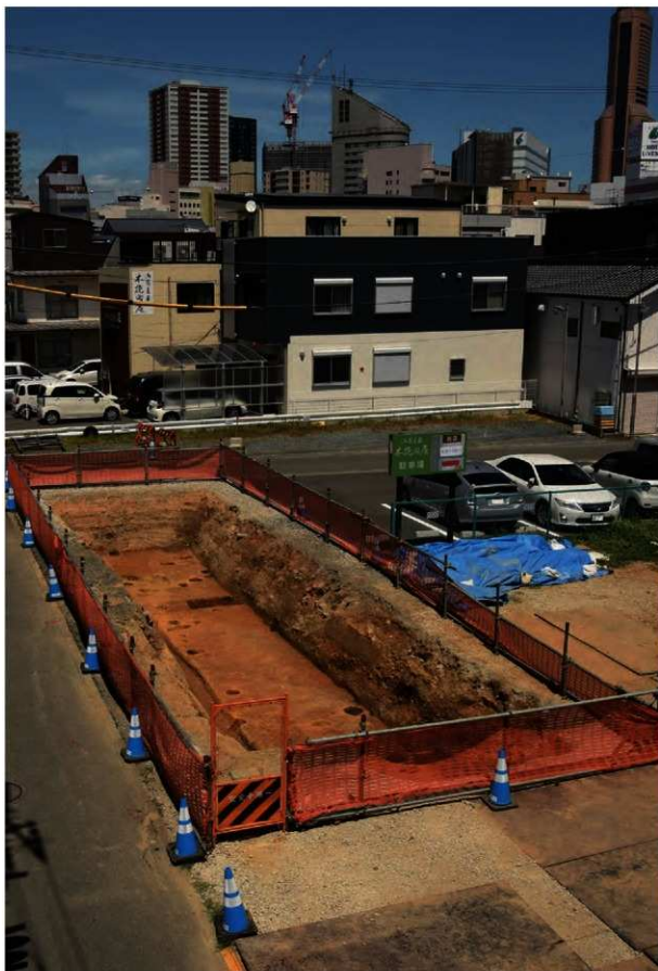
1 II a 区 完掘全景（南西から）
