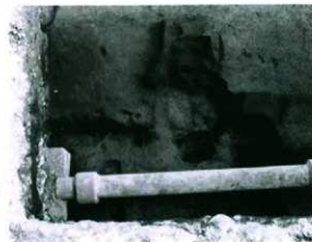
8. SI767住居掘方（西から）
