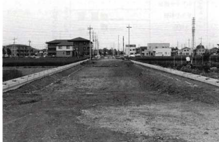
写真1 掘削前の様子（西から） 都市計画道路建設予定地の中で最後まで残されたカ所である。 現況は、水田と畑として使われていた。
