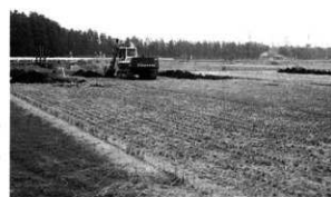
写真23 調査地掘削中（北西から）
