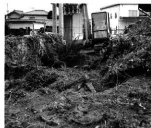
写14 掘削作業状況 南西から
